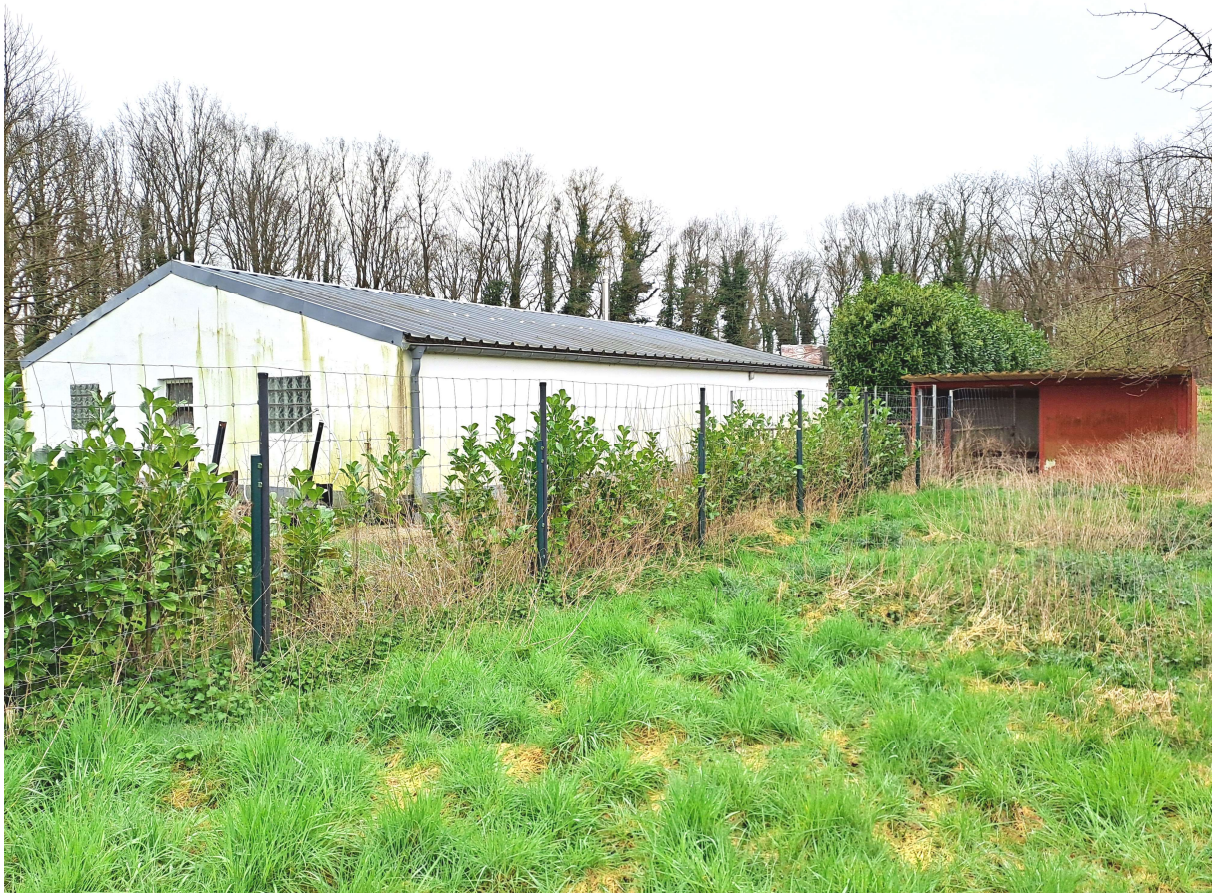
Bild 4: Gemauerte, ehemals landwirtschaftlich genutzte Lagerhalle mit Dach aus Trapezblech; rechts kleiner, offener Unterstand für Damwild aus Trapezblech (eigene Aufnahme, 26.03.2024)
