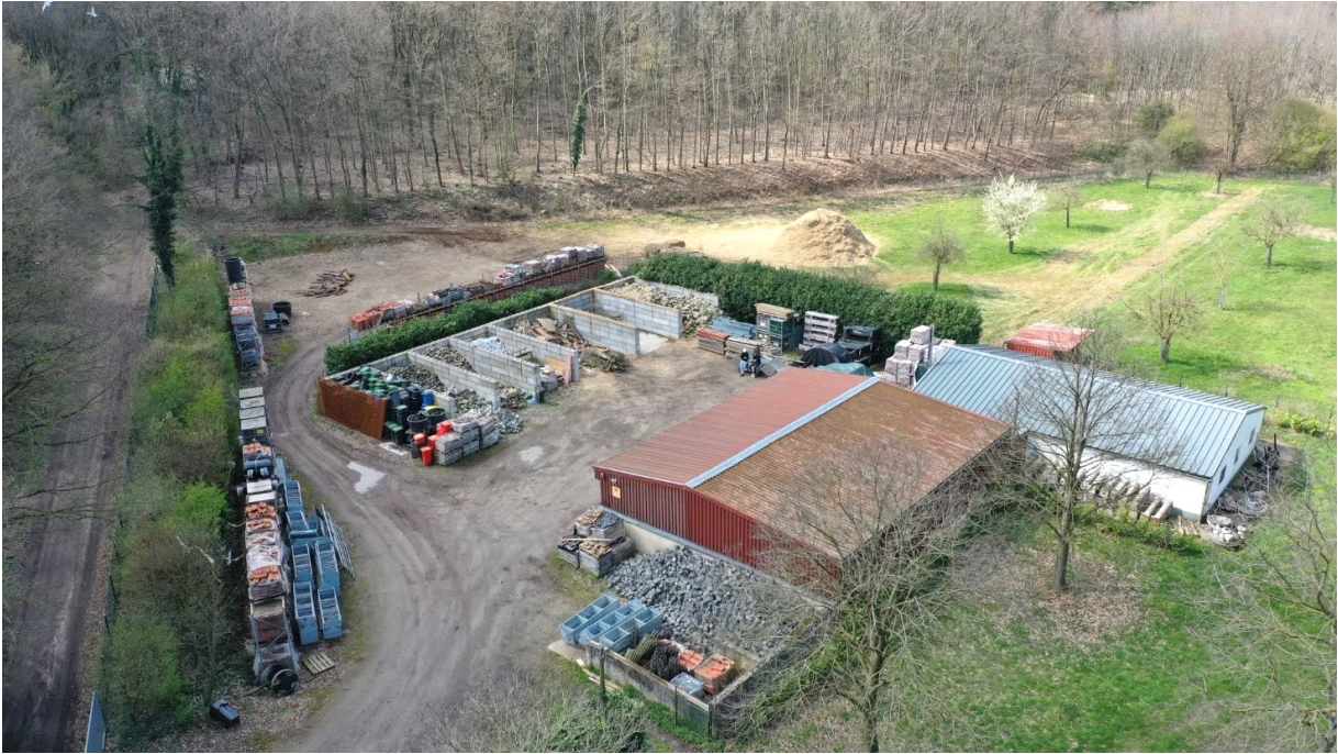
Bild 1: Schrägluftbildaufnahme auf das Plangebiet aus südöstlicher Richtung (noch ohne Zufahrt) (IRRLAND GMBH UND Co KG, 2023)
