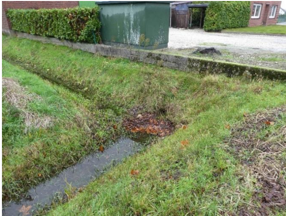
Foto 23: Laufrichtungsänderung im Bereich ...
