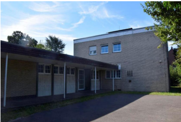
Die Gebäude verfügten über eine umlaufende Attika, Rollladenkästen und tlw. abstehende Teerpappe.
