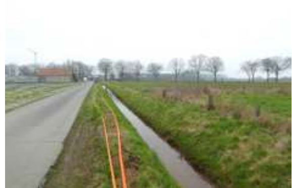
Foto 12: ... trifft auf Wember Straße im Norden
